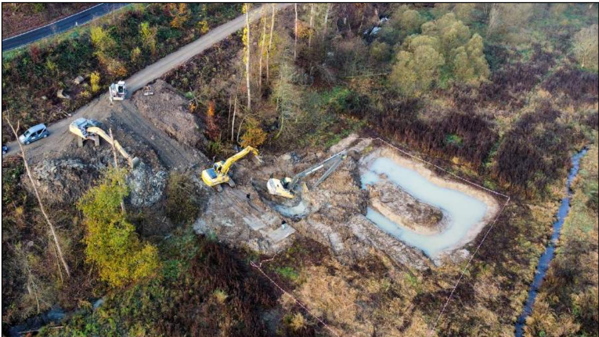
Erdarbeiten zur Anlage von Amphibienlaichtümpeln oberhalb von „Tüschbachs Weiher“
