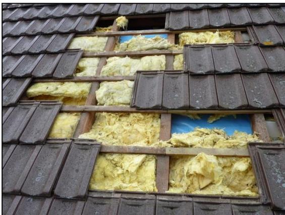
Abb. 15: Durch Steinmarder zerstörte Dachisolierung
