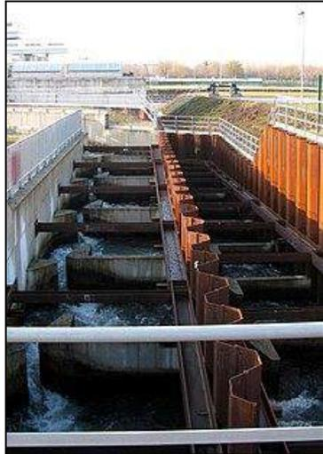
Abb. 23: Fischpass am Kraftwerk Rheinau (Oberrhein), auf 290 m Länge werden 10 m Höhenmeter überwunden
